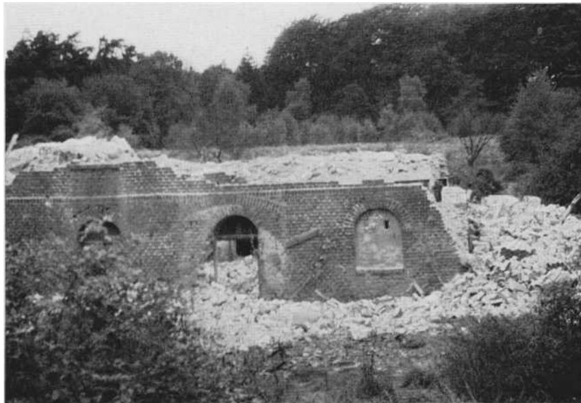
Am Teufelshorn 1967 – Ruine des letzten Zechengebäudes
